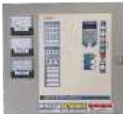
自動始動発電機盤
